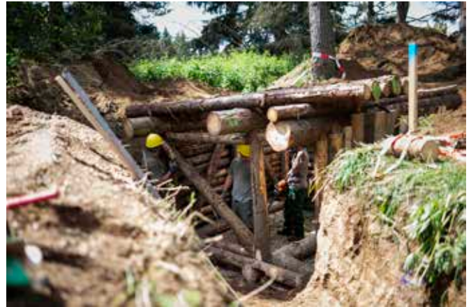
Bau eines Unterstandes im Gelände.
