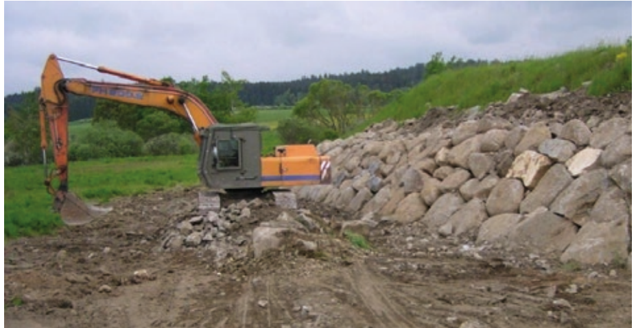
Sanierung des Schießdamms auf der Schießbahn Kühbach mit Auslegesteinen durch den splittergeschützten Raupenbagger. ▲
