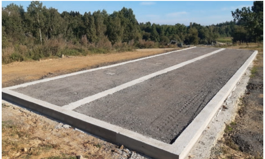
Errichtung Streifenfundament, ausgefüllt mit Recyclingmaterial. ▼
