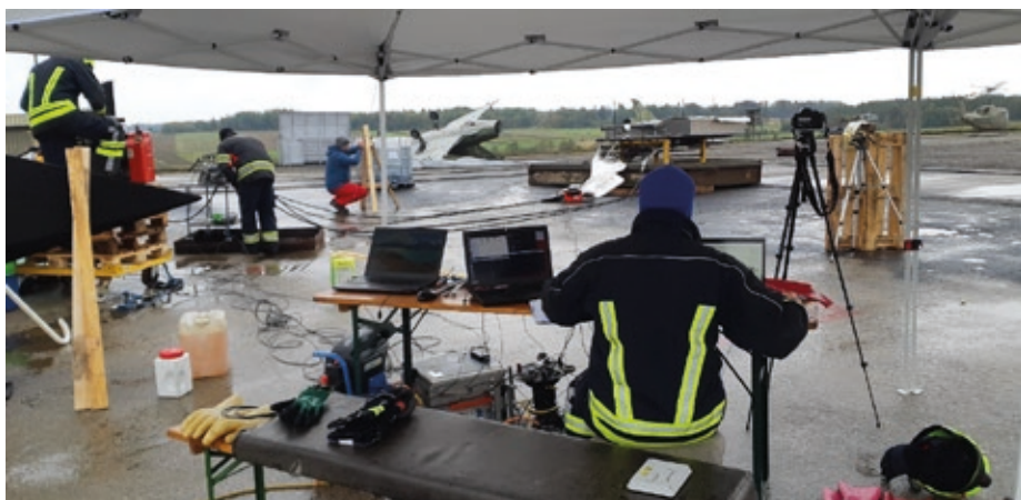
▲ Umfangreiche Vorarbeiten waren notwendig, um die Testinfrastruktur aufzubauen.
