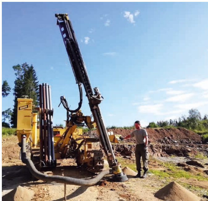
Das Bohren der Bohrlöcher erfordert präzises Arbeiten. ▲
