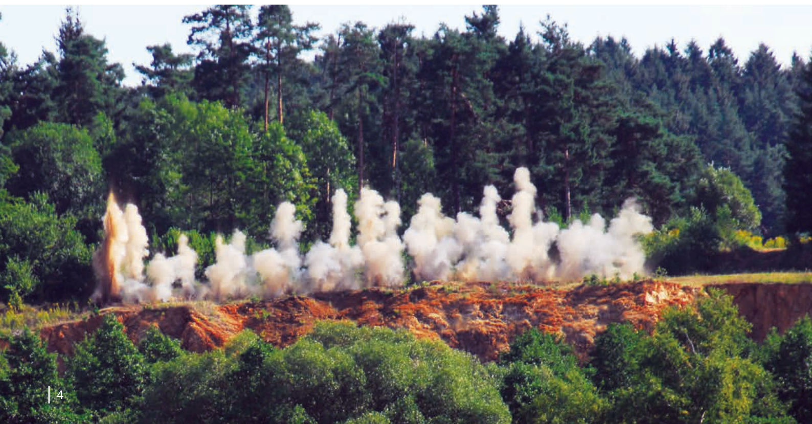
Das Zünden der Sprengladungen erfolgt gestaffelt innerhalb von Millisekunden. ▼
