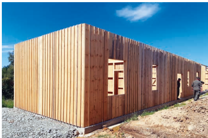
▲ Bereits fertig aufgestelltes Reihenhäuser.
