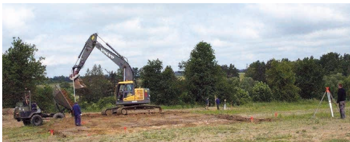
▲ Kettenbagger beim Einrichten der Fundamenthöhe mit Lasernivelliergerät.
