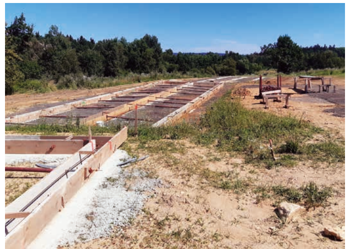
▲ Vorbereitungstätigkeiten zur Errichtung des Betonfundamentes.
