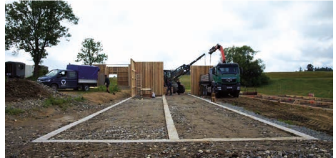
Hand in Hand gehen die Arbeiten weiter, ein Fortschritt ist deutlich zu erkennen. ▲
