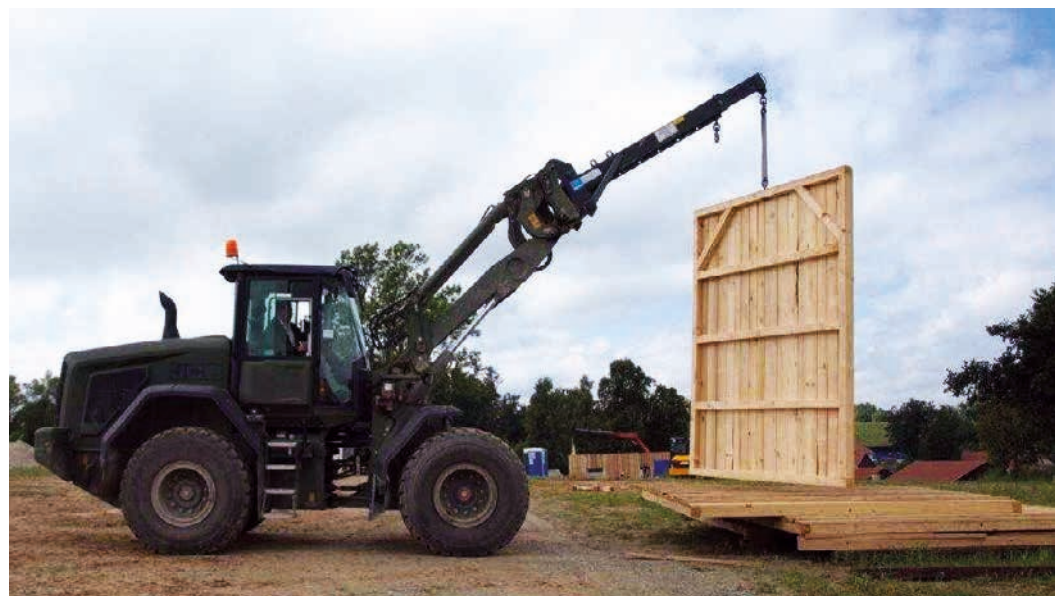
Radlader mit Lasthakenarm bei der Manipulation der Holzfertigteillemente. ▼
