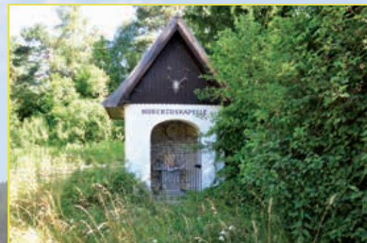
Die HUBERTUSKAPELLE im Raum Döllersheim West
